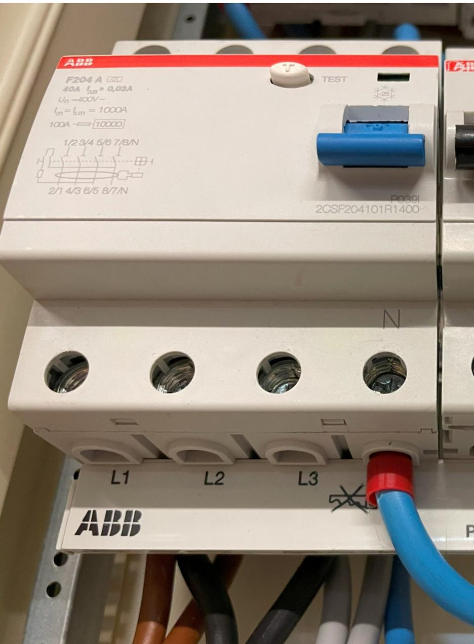
„In diesen beiden dargestellten Konstellationen der RCD-Hersteller ABB und Siemens können die Schraubenköpfe geringfügig höhenversetzt sein. Dies entspricht zulässigen Toleranzen und beeinträchtigt die Funktion und Sicherheit des RCD nicht; lediglich beim Einsatz unserer RCD-Messadapter kann das planauffliegende Ansetzen erschwert sein.“
